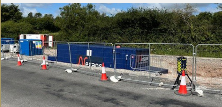
Coimeádán Nexans i mbá comhpháirteach feadh bhealach an chábla, ina gceanglaíonn speisialtóirí le chéile faid an chábla.
