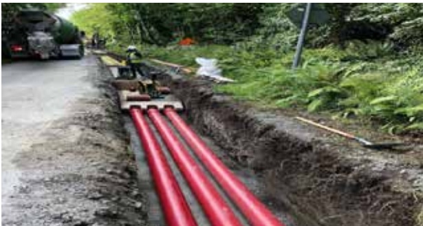
Fíor 5: Gnáthshuiteáil ducta cábla sa bhóthar
