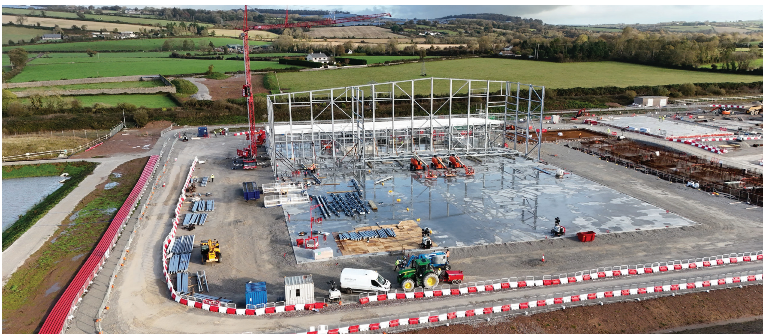
Cóimeáil oibreacha cruach fhoirgneamh an tiontaire ag láithreán an stáisiúin tiontaire ag Baile Adaim.
