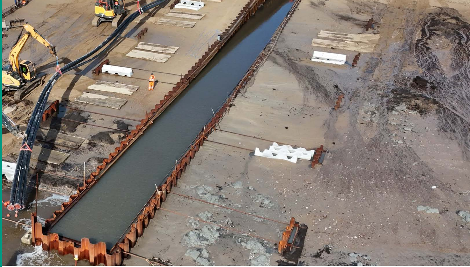
Piobáin ductála á n-ardú go sioncronach chuig an gcóradhamba (trinse) ag Trá an Chaisleán Chria, Márta 2025.
