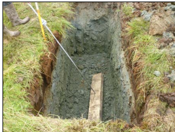
Stay rod trench
