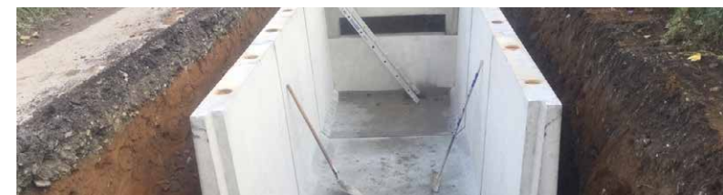
Figiúr 5: Bá tipiciúil siúntála ina bhfuil cáblaí ceangailte
