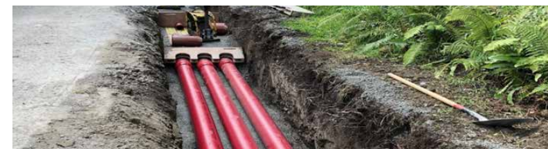
Figiúr 4: Suiteáil duct cábla tipiciúil sa bhóthar
