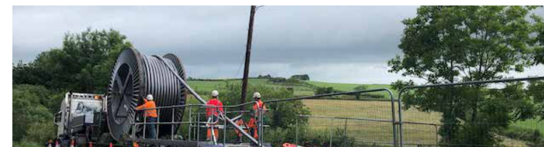
Figiúr 6: Cáblaí á dtarraingt isteach sa ducts agus bá siontáil
