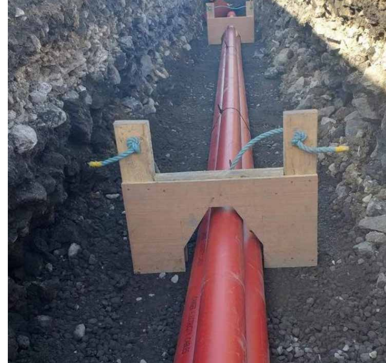
Figiúr 2: Suiteáil duct cábla tipiciúil sa bhóthar
