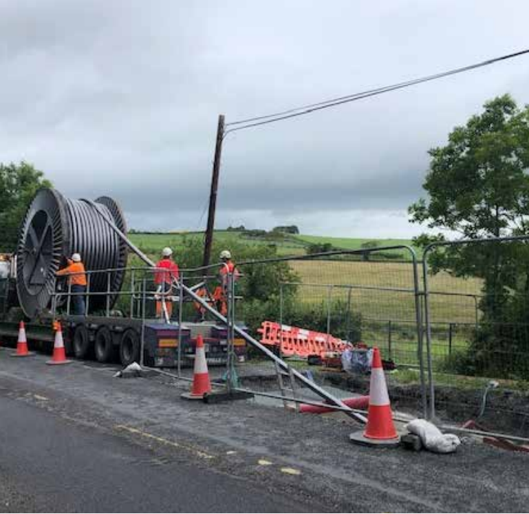
Figiúr 4: Cáblaí á dtarraingt isteach sa ducts agus bá siúntáil
