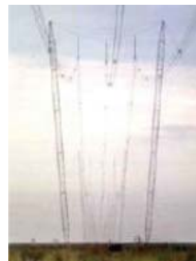
500kV Invisible Cross Ropes Argentina
